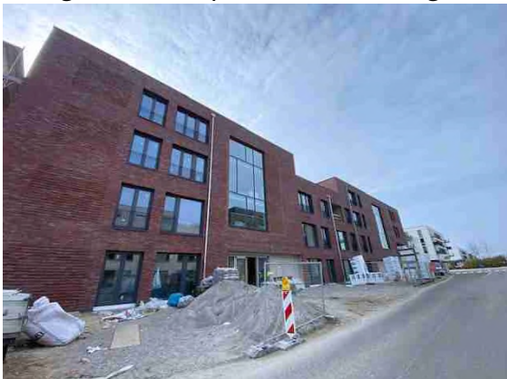
Neubau Lübecker Straße 74-78 – im März 2024
